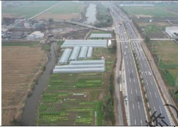
项目中间段现状
