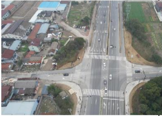
项目起点段现状
